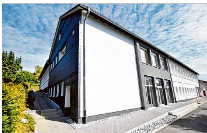
Neue Farben für die „alte Schule“. Links am Gebäude vorbei wurde ein neuer Zugang geschaffen, der über eine Außentreppe unter das Dach führt.
