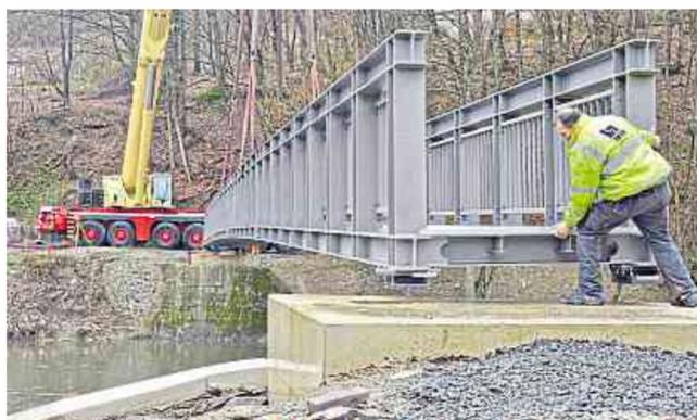
Punktlandung der neuen Brücke gegen 12.30 Uhr. Die Stahlkonstruktion konnte auf den Widerlagern aufgesetzt und ausgerichtet werden.
